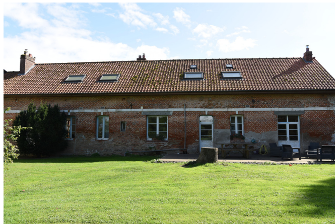
Façade arrière de la bâtisse
